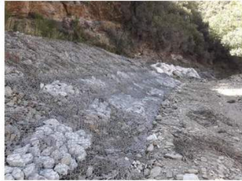
Photo 3 : Rechargement des cages en gabions détériorées (18/10/19)
