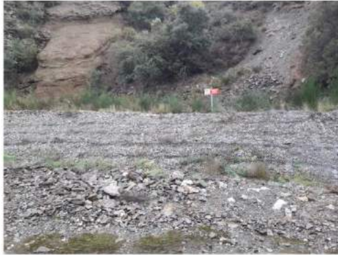
Photo 6 : Panneau mis en place en pied de versé (12/11/19)
