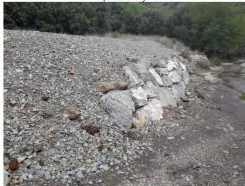
Photo 11 : Mise en place d'enrochements le long du Grésillou (24/10/19)
