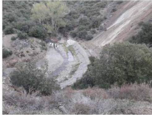
Photo 7 : Vue d'ensemble de la protection du pied de versé (12/11/19)
