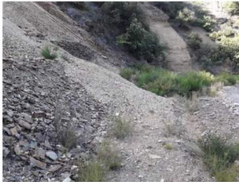
Photo 4 : Glissement localisé des produits de la versé avant enlèvement (27/06/19)
