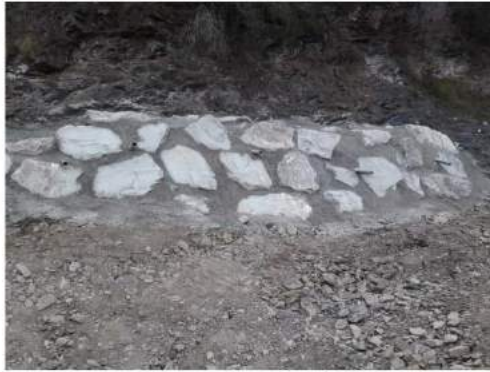
Photo 2 : Protection en enrochement en sortie de virage (18/10/19)
