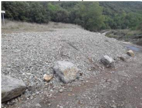
Photo 10 : Remise en place d'une couverture de la plateforme Marty (24/10/19)
